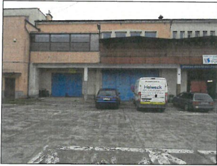
Elewacja budynku, na parterze i piętrze znajduje się lokal Nr 2
