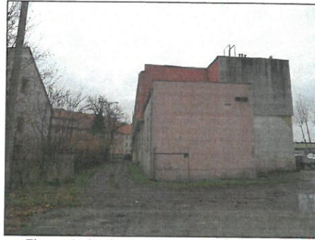
Elewacja budynku, teren wokół budynku
