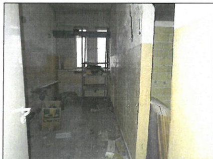
Pomieszczenie socjalne na piętrze
