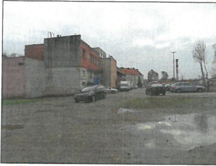
Elewacja budynku, teren wokół budynku
