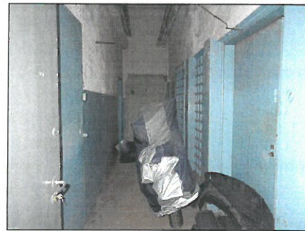
Korytarz z wejściem do pomieszczeń
