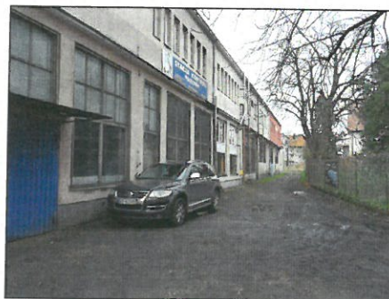
Elewacja wschodnia budynku
