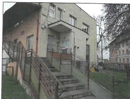
Schody wejściowe do pomieszczeń na 1 piętrze
